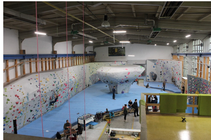
Neue Beleuchtung mit LED Hallentiefstrahlern
